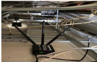
点検口内に解錠接点が確保できる場合は、優先的に点検口への設置を行います。
